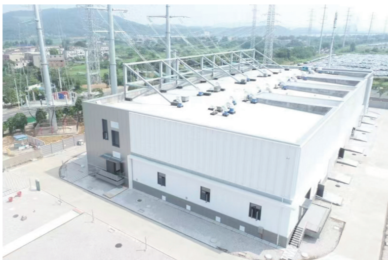
株洲新马220千伏输电变电工程外景。通讯员供图
