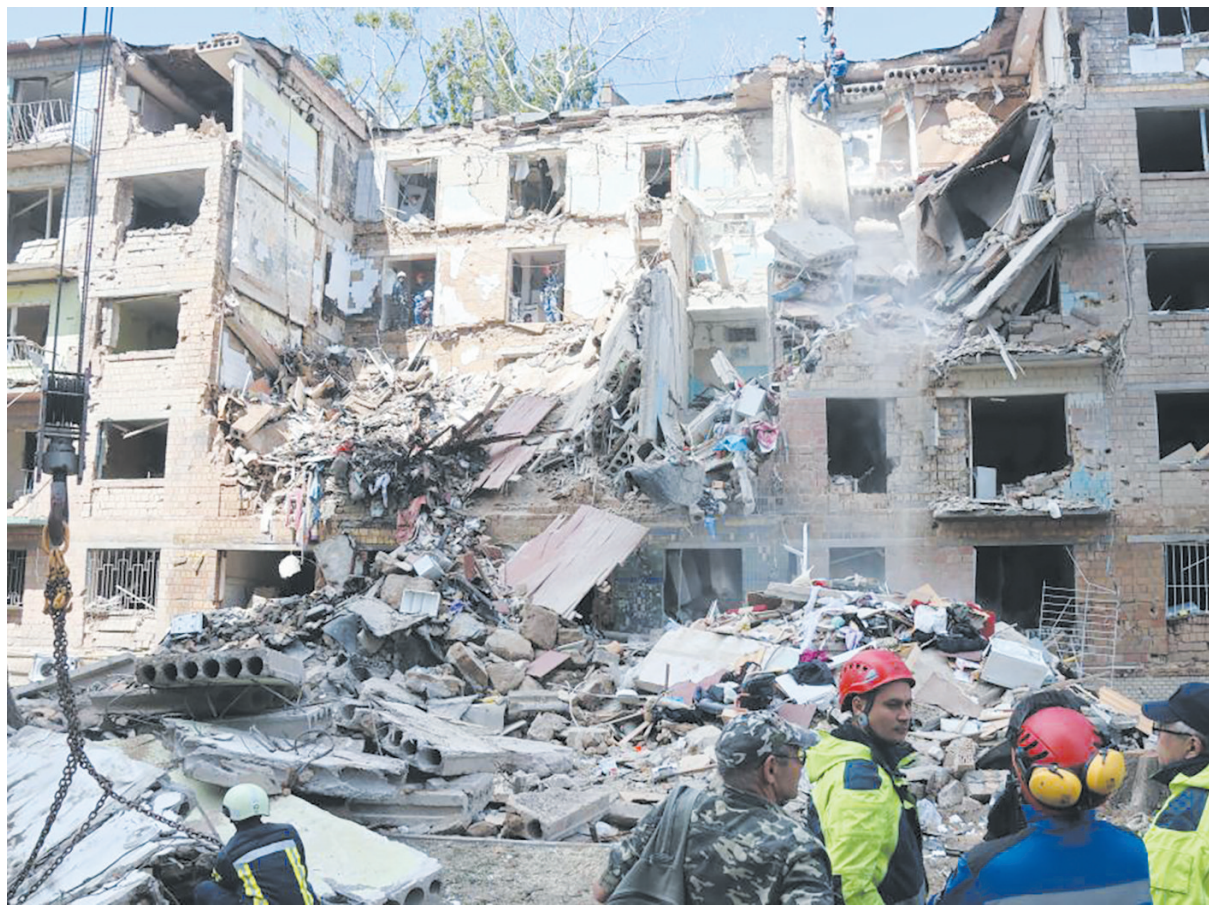
6月23日,乌克兰国家紧急情况局说,当天凌晨俄军对乌首都基辅发动空袭。图为该局工作人员当天在基辅市舍甫琴科夫斯基区遭空袭现场进行搜寻和清理工作。新华社发(彼得·德鲁克摄)
