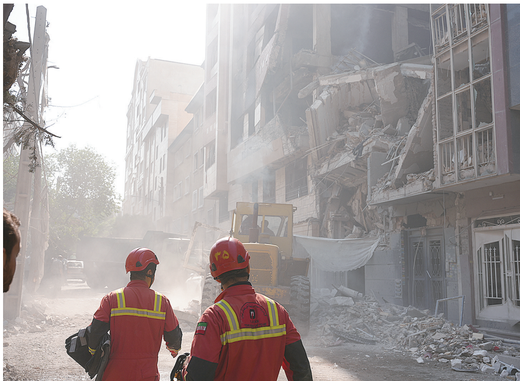
6月13日在伊朗首都德黑兰拍摄的在以军袭击中受损的建筑。
