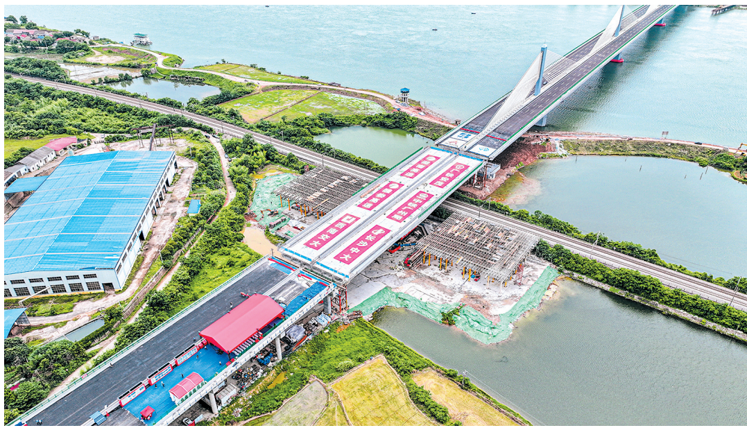
醴娄高速湘江特大桥上跨京广铁路转体桥成功实现毫米级精准对接。
