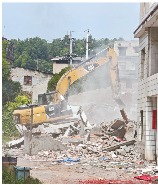
6月9日谭家墩城改集中拆除房屋现场。记者/杨凌凌 摄
