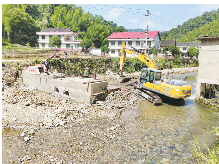
建设中的漂流项目。通讯员供图
