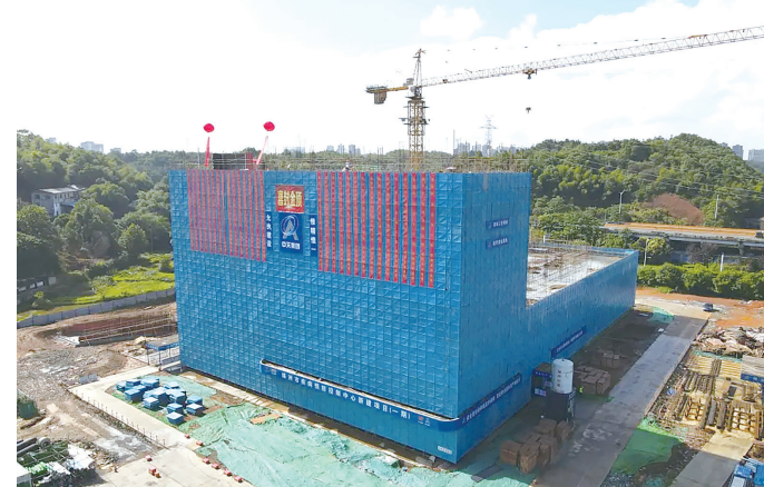
市疾病预防控制中心新建项目(一期)结构顺利封顶。记者/张威 摄
