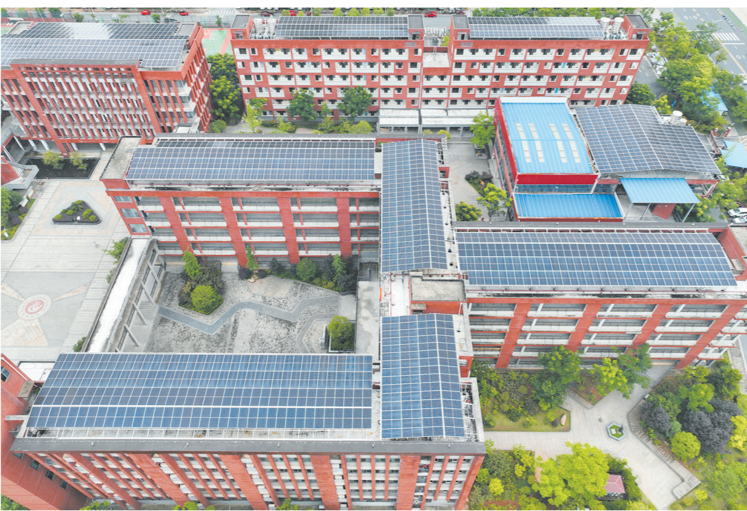
图为株洲市二中初中部1MW分布式光伏发电项目,受访企业供图
