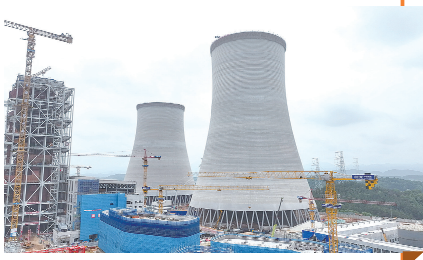
大唐华银株洲2×100万千瓦扩能升级改造项目1号冷却塔顺利结顶。李琴露 供图
