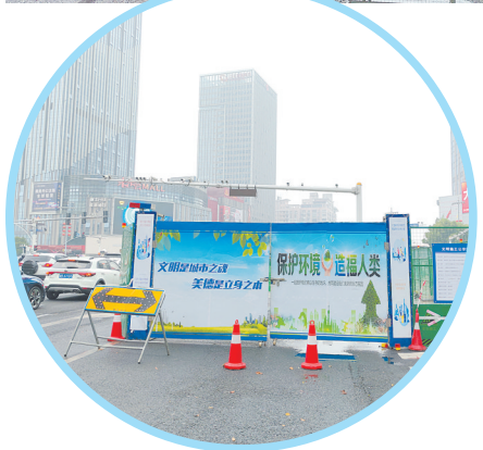
长江北路上的一处破占道施工工地。 记者/肖星平 摄
