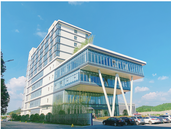
位于荷塘区的中天杭萧研发楼是我市首个钢结构装配式项目。 资料图/ 记者 张威 摄
