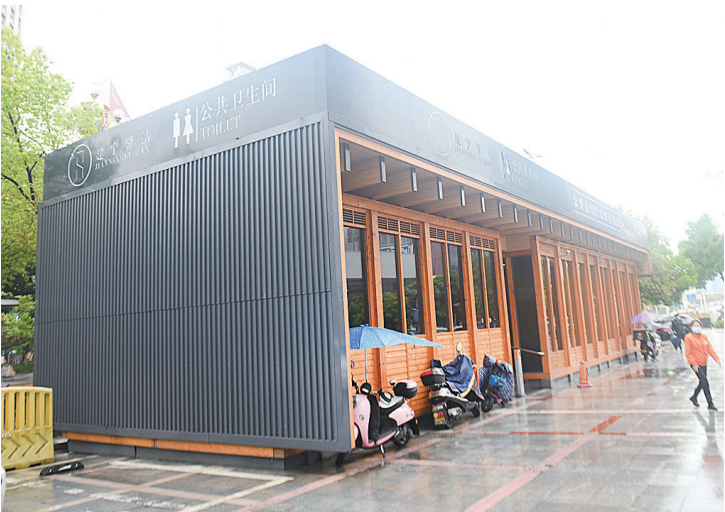
采用钢结构装配式建筑项目建宁驿站。 资料图/记者 张威 摄
