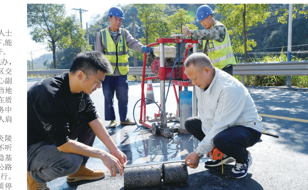
现场测试铺设厚度是否达标。 通讯员供图
