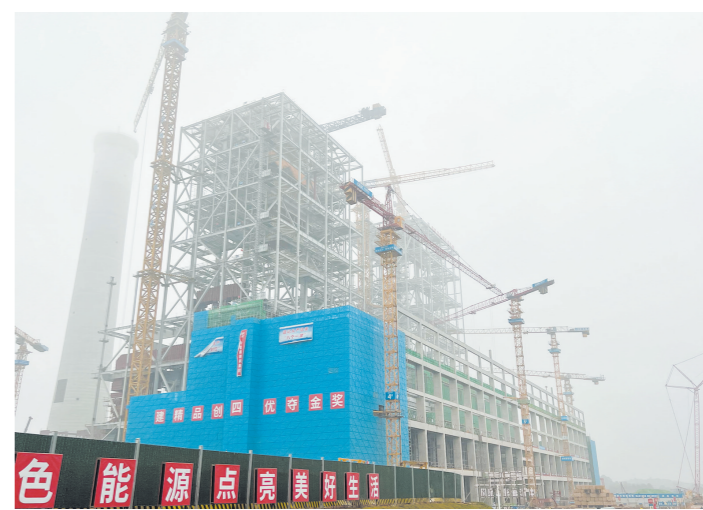
作为核心的主厂房本月中旬将全面封顶。记者/张威 摄
