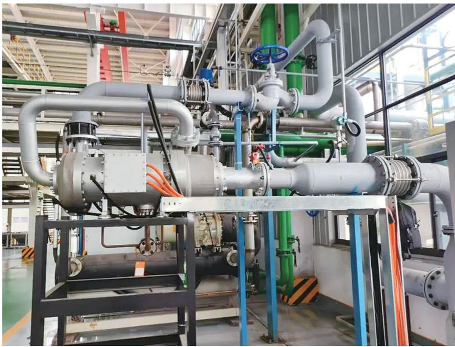
中车株洲电机公司推出的无油磁悬浮变频高温工业热泵。 企业供图
