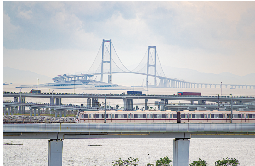
6月19日,深圳地铁11号线列车和广深沿江高速上的车辆经过深中通道的深中大桥和西人工岛。 新华社记者 毛思倩 摄
