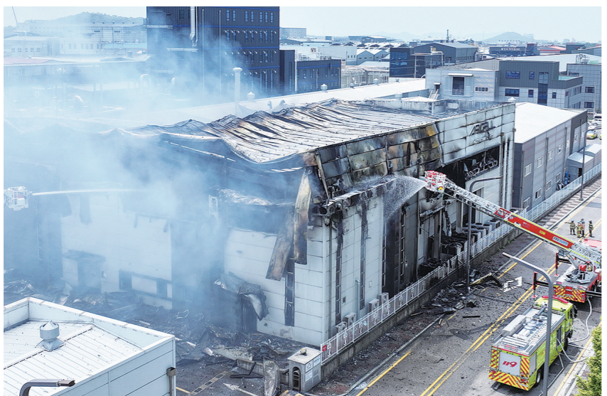
6月24日,消防员在韩国京畿道华城市的电池工厂火灾现场灭火。 新华社/美联
