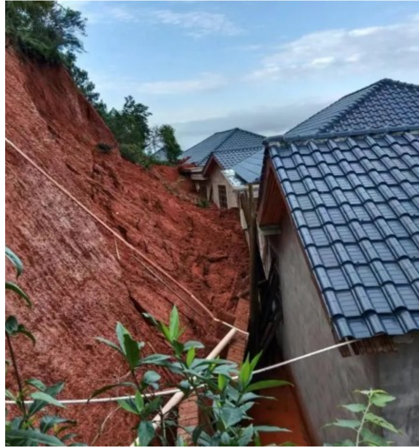
强降雨而至山体滑坡,损害了村民房屋。所幸转移及时,没有人员伤亡。 通讯员 供图
