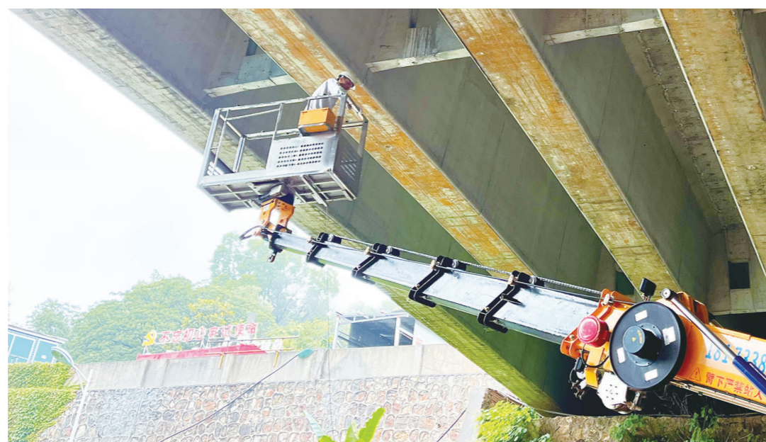
响田大桥新桥下，技术人员为大桥“体检”布置检测点。
