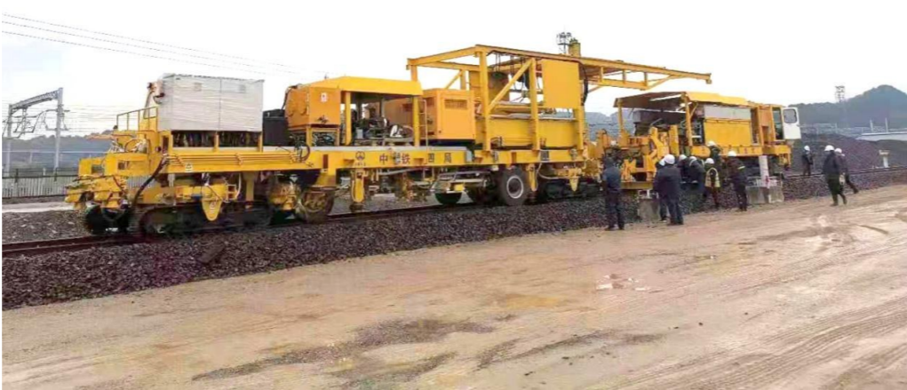
智能铺轨机正在进行测试。通讯员供图
