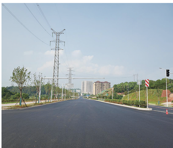
新塘路四期项目现场。记者/向胤蓉 摄
