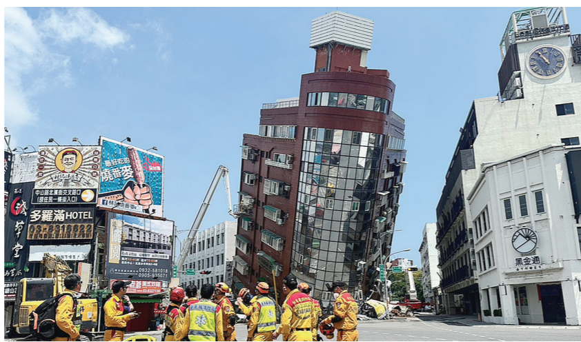
在花莲市,地震造成一栋大楼严重倾斜(4月3日摄)。新华社发(台湾中时新闻网供图)
