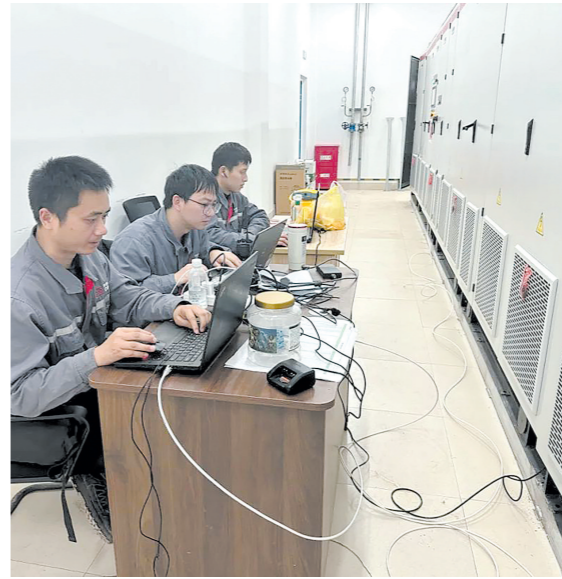
技术人员正在现场调试设备。 通讯员供图
