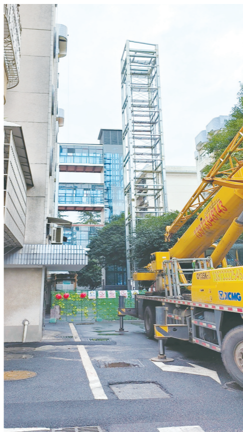
天台路人民银行小区,电梯加装工程按下“加速键”。 通讯员 供图
