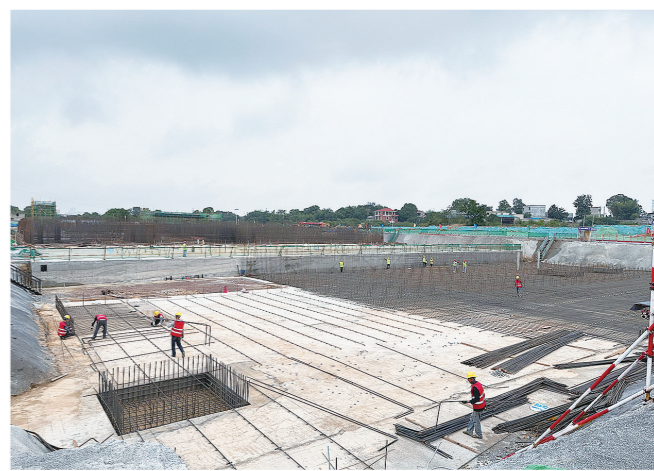
群丰污水处理厂一期沉淀池进入施工阶段。 记者/张威 摄
