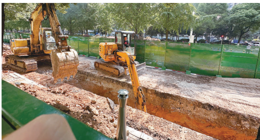
庐山上两台挖土机同时开挖抢进度。株洲日报全媒体记者/张威 摄
