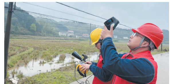
工作人员冒着炎炎烈日,检查供电线路设备。通讯员 供图
