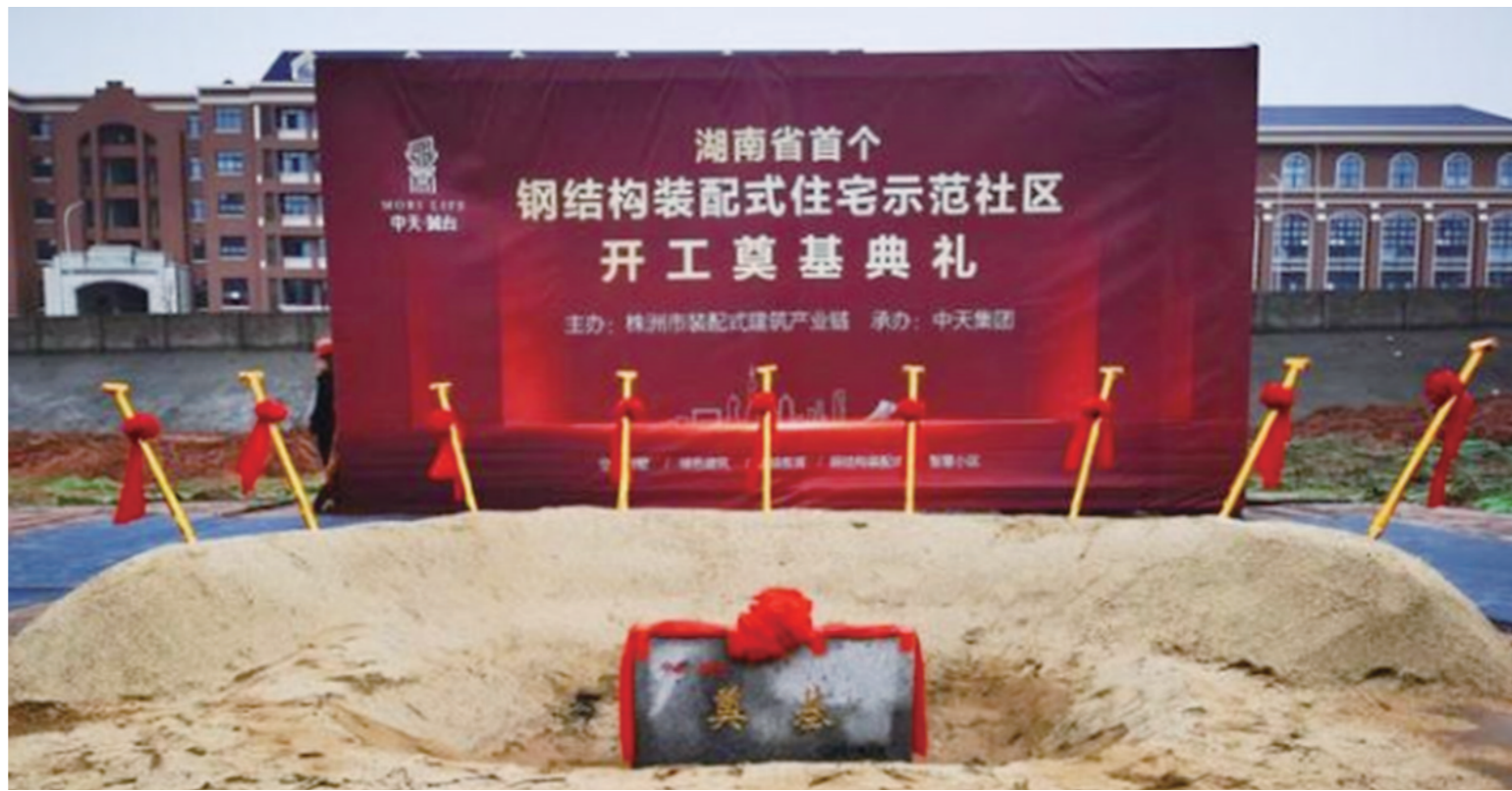
湖南首个钢结构装配式住宅示范项目——中天·麓台。
