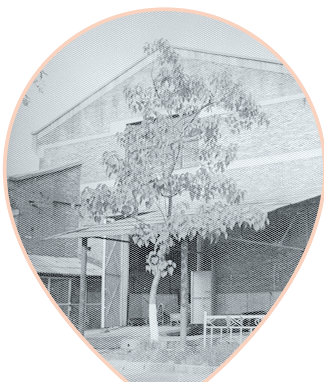
1972年建变变压器车间
