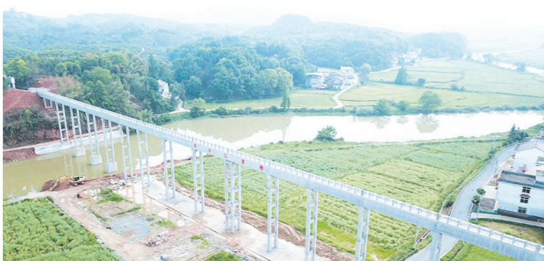
清水江渡槽实现通水。株洲日报全媒体记者/王军 通讯员/谭琦 摄
