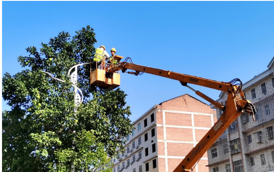
烈日下,工作人员更换老旧路灯。通讯员 供图
