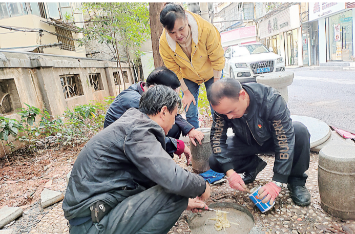
党员及热心群众修缮小区基础设施。通讯员供图
