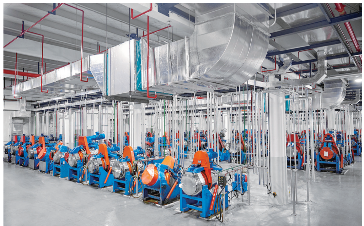
株硬集团型材分公司混合料生产线。
