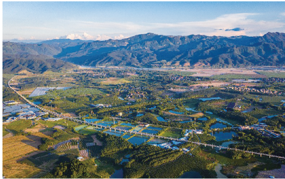
中老铁路橄榄坝特大桥。据新华社
