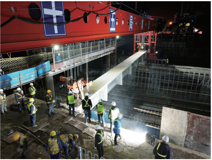
▲新华桥东侧最后一片T梁吊离施工现场。通讯员/唐文健 摄
