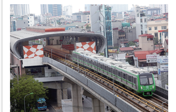
中企承建的越南首条城市轻轨项目交接仪式11月6日在越南首都河内举行,标志着该项目投入运行。该项目对完善河内城市路网功能、缓解交通压力、促进区域经济发展有重要意义。图为11月6日,列车在越南首都河内吉灵-河东轻轨线上行驶。
