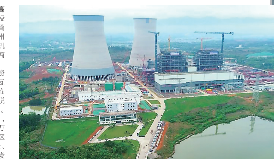
湖南火电承建的永州电厂项目。受访企业供图
