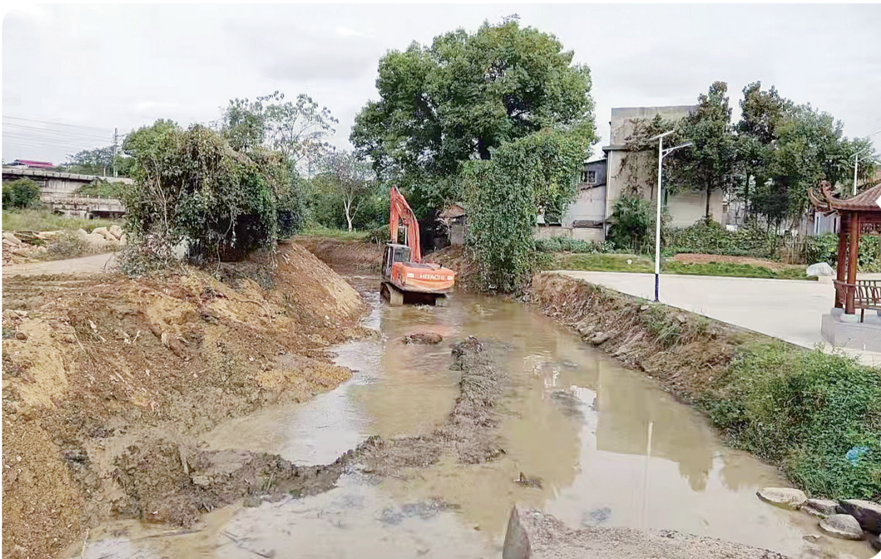
白关镇对枫溪港河道进行清淤除杂。 株洲日报·掌上株洲记者/俞强年 通讯员/朱路 摄
