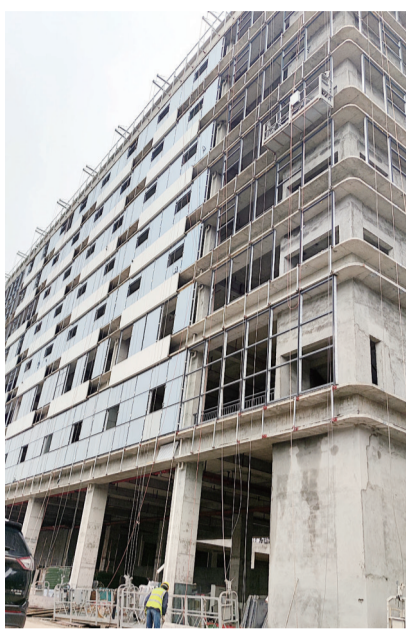
欧微服饰总部基地二期施工现场。株洲日报·掌上株洲记者/杨凌 摄
