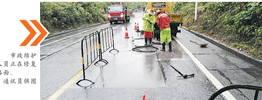
市政维护人员正在修复路面。通讯员供图
