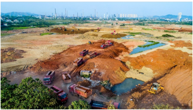
土地修复工程。
