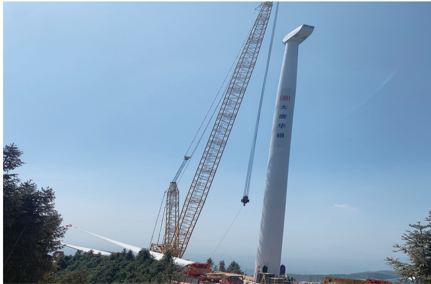
明月风电第一台风机塔筒、机舱吊装到位。 通讯员供图
