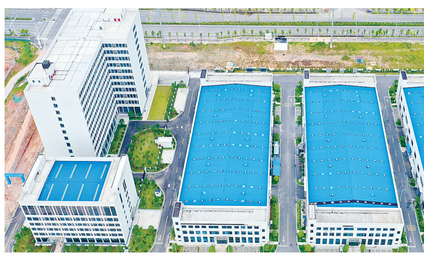
航空城科创园一期项目已投用
