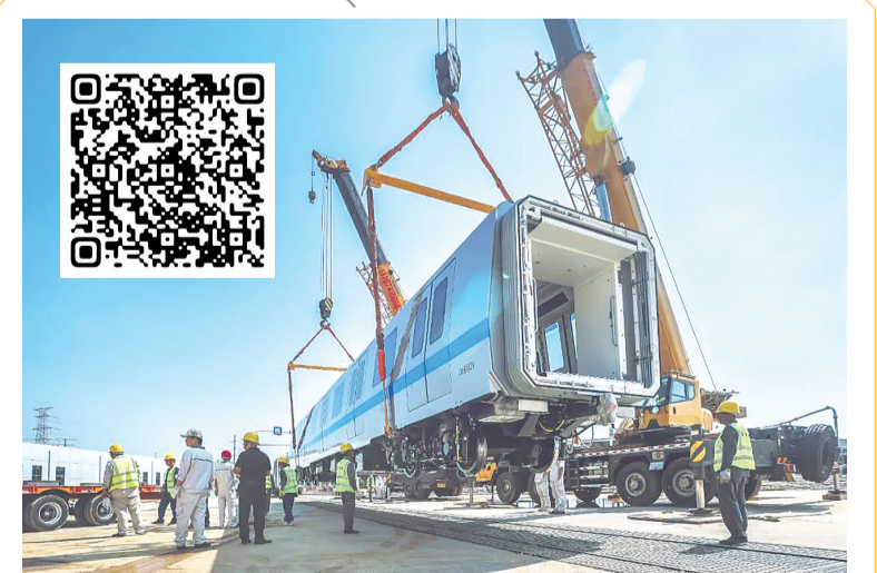
6号线车辆运抵现场
