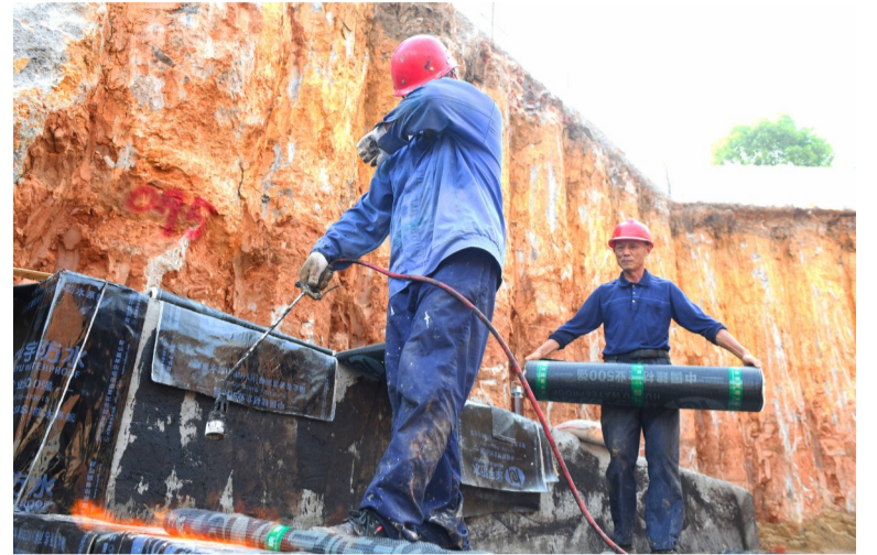
余师傅在近60℃的高温下用煤气铺设防水毡。
