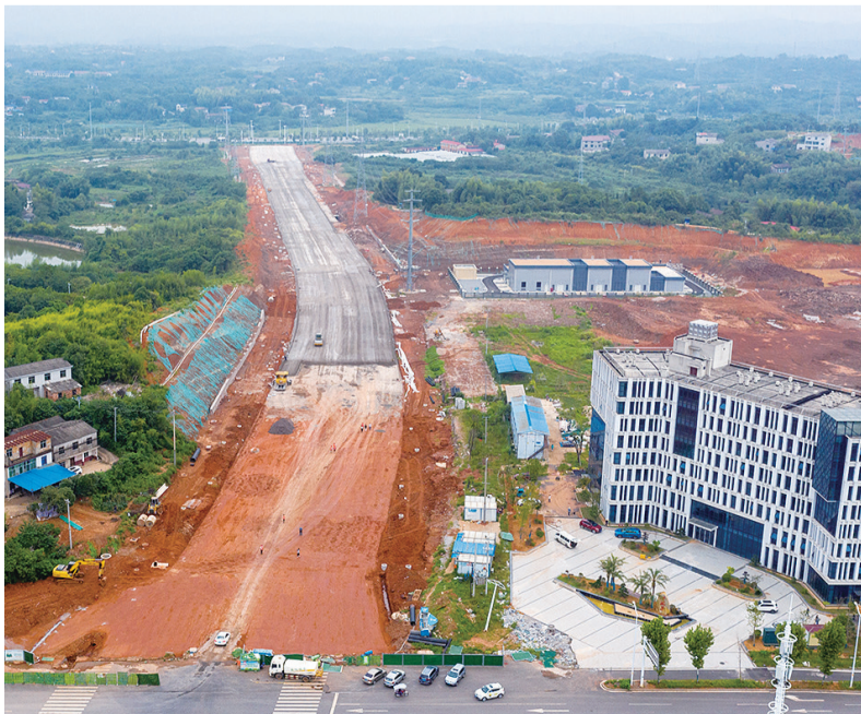
8月27日,从空中俯瞰南洲新区01号道路施工现场,道路已经基本成形,预计年底完工。道路西起涑口区涑湘大道,往东延伸,终点接南洲大道,道路全长约1公里,双向六车道,设计行车时速为60公里,为区域内重要的东西向主干道。 株洲日报·掌上株洲记者/刘震 李翰 摄
