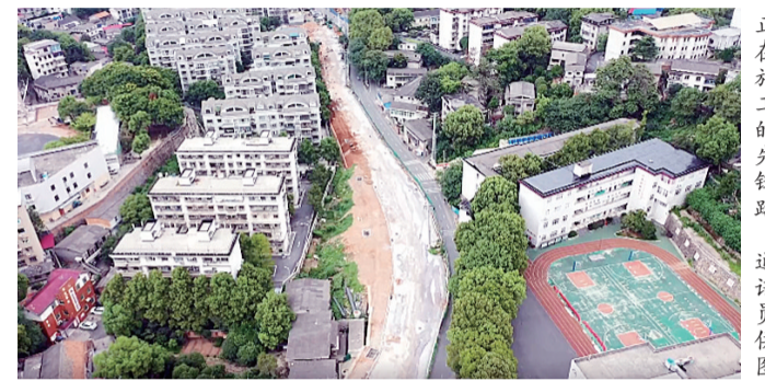
正在施工的先锋路。通讯员供图
