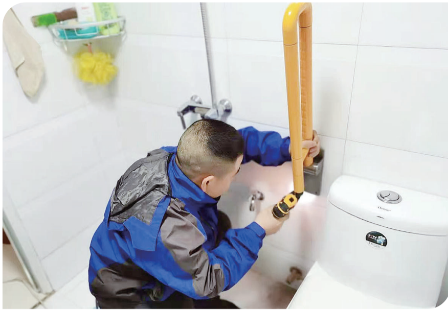
工作人员正在进行适老化改造。通讯员供图
