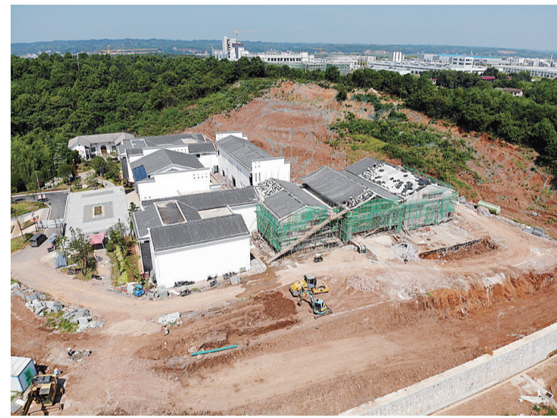
涿口博物馆项目二期建设现场。邹怡敏 摄
