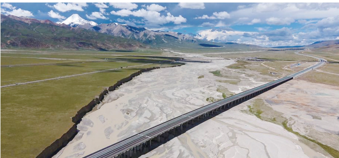
资料图为6月28日,西藏那拉高速公路及远处的雪山。据中新网
