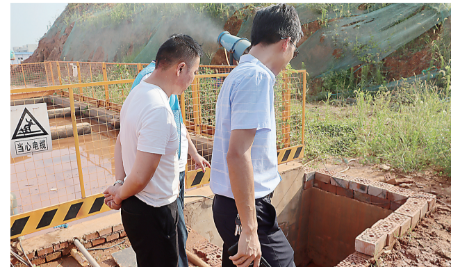
天元区河长办督查施工现场 通讯员 供图
