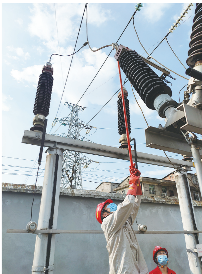
工作人员正在进行电力设备维护。企业供图
