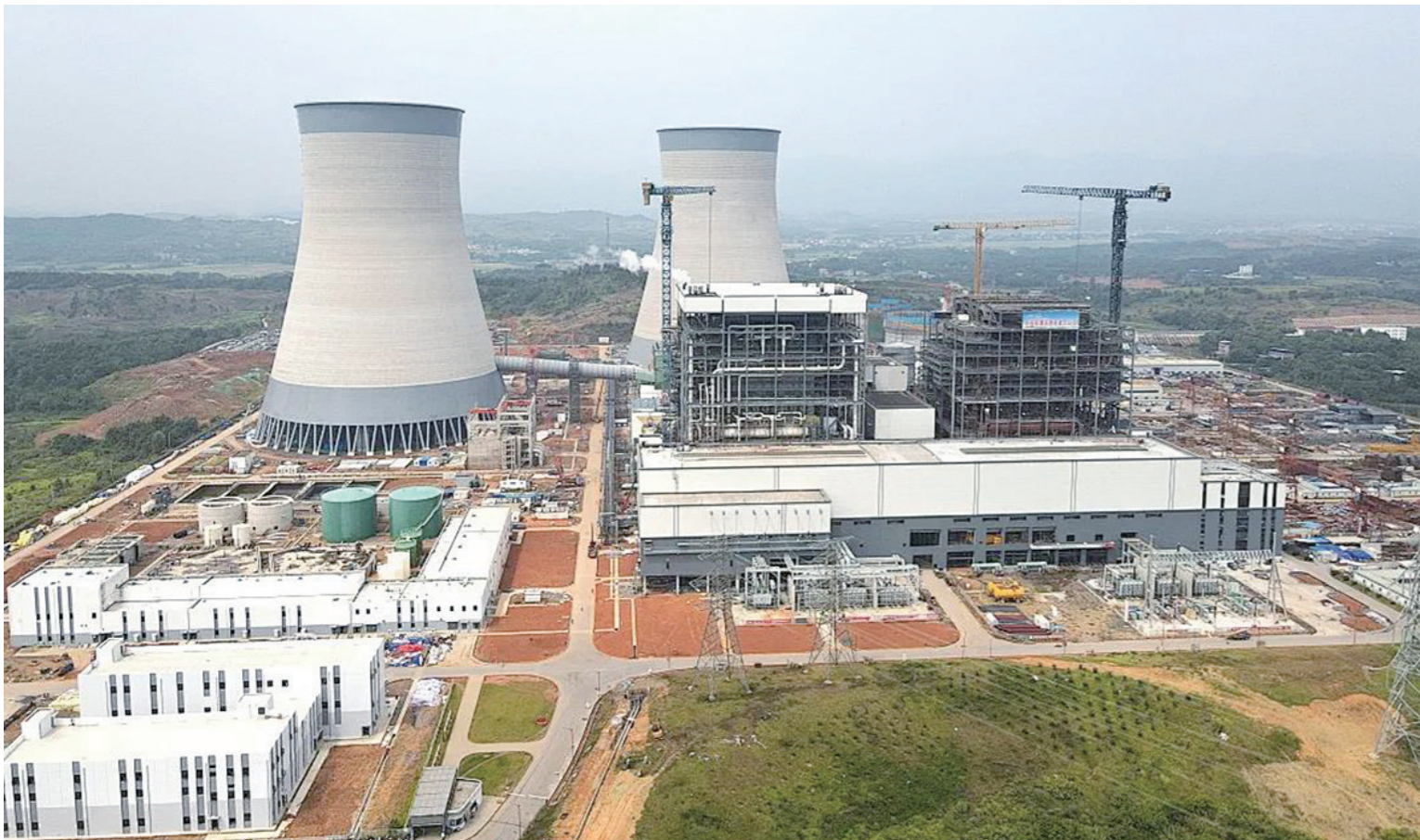
国能湖南永州电厂项目建设现场。企业供图
